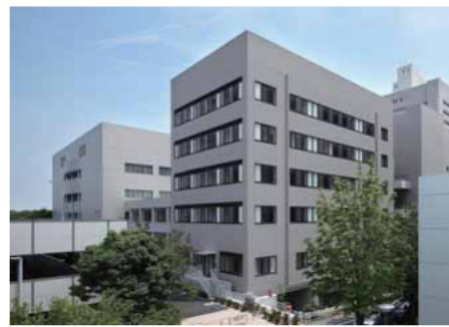
オンコロジーセンター棟
