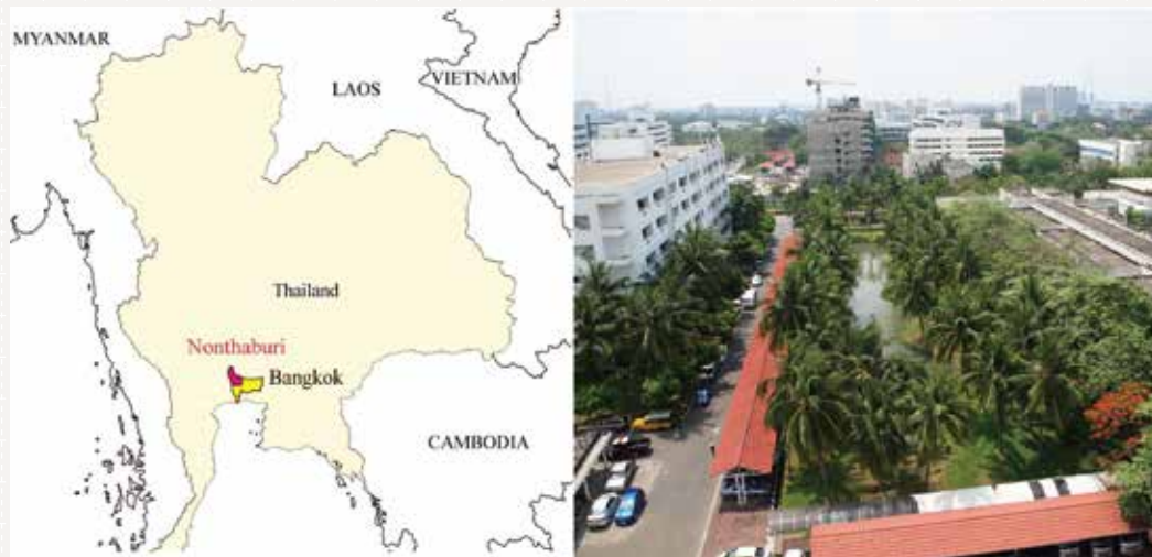
共同研究センターはバンコク近郊ノンタブリにある保健省・医科学局・タイ国立予防衛生研究所内に設置されている。
